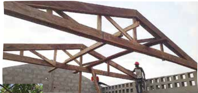
Pose de la charpente
