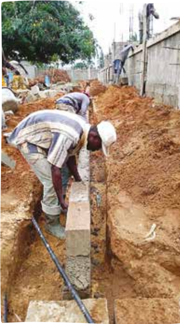
Démarrage du chantier
