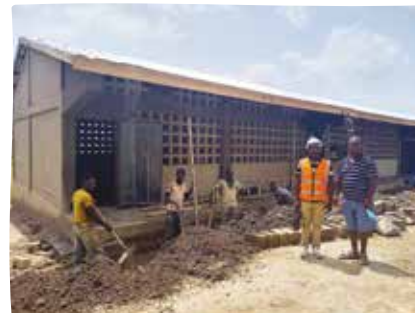
Chantier de l'école de Zongo de Kpalimé au Togo
