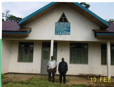
Centre de santé au Kivu (RDC)
