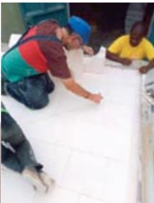
**3) Pose de l'entrée du four et traçage du four** proprement dit, une ficelle, un clou et un crayon serviront de compas, le four fait 1,8 m de diamètre, légèrement allongé de 40 cm supplémentaires. La première rangée est mise en place. Vous aurez remarqué la présence du manuel de montage Le Panyol que nous ne quittons pas des yeux, c'est notre bible...
