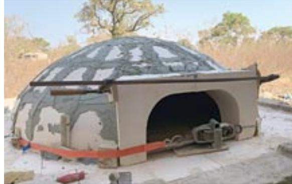
8) **Enduit et ceinture de ciment autour du four**, pose de la cheminée et démarrage de la construction des murs autour de la voûte, cette fois ci ça prend tournure. Tout le monde bosse, comme il fait chaud l'enduit sèche vite, Max prend la pelle pour préparer le ciment, d'autres talochent, d'autres mouillent, percent, et les murs commencent à s'élever.
