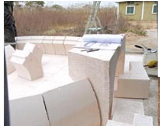
4) **Mise en place des supports de voûte** et pose du cric de camion qui va supporter l'ensemble (les romains faisaient déjà comme ça...) et on avance rangée par rangée...
