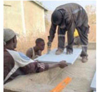
**2) Pose de la chamotte** (sable réfractaire) sur 8 cm d'épaisseur et pose des dalles de la sole du four. Premier piège, la planéité doit être parfaite dans tous les sens et ce n'est pas facile à réaliser : c'est la base du four et tout va reposer ici ; nous mettrons la journée mais le résultat sera là.
